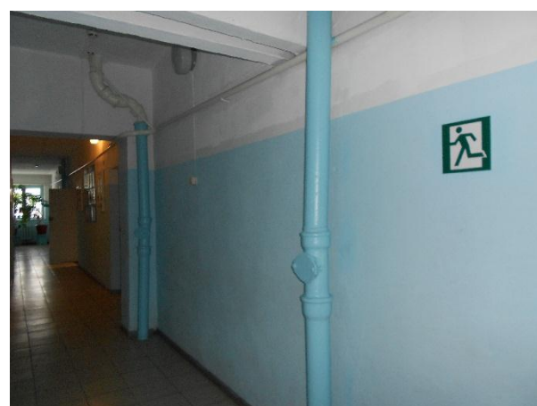
Фото № 6 Пути эвакуации
