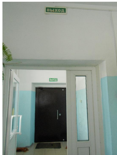
Фото № 8 Пути эвакуации
